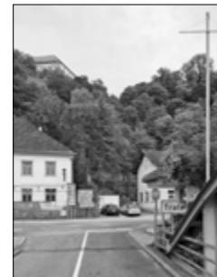
Gebäudeensemble am Brückenkopf Trate, Blick auf den Schlosshügel
