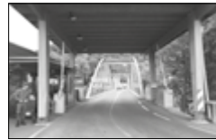
Vergleich mit der heutigen Situation: Das Flugdach des ehemaligen Grenzpostens verdeckt die Sicht auf das Schloss.
