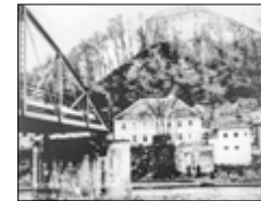
Am letzten Kriegstag 1945 wurde der slowenische Teil der Brücke von der deutschen Wehrmacht gesprengt. (Private Fotografie, in: Felix Kreisler: Damals in Mureck, Eigenverlag der Stadtgemeinde Mureck, Mureck, 2002, S.76)
