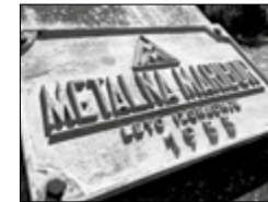
Die Brücke wurde 1955 wiedererrichtet. Tafel des ausführenden Unternehmens an der Brücke
